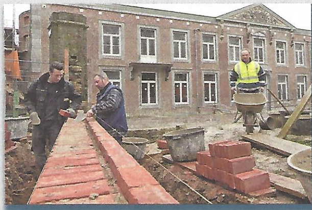
Een 'social return'-project bij de restauratie van klooster Hoogcruts in Slenaken.
