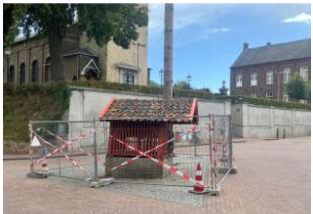
De zwingelput bij de kerk in het dorpscentrum ging vorige maand in de steigers voor een grondige restauratie.
